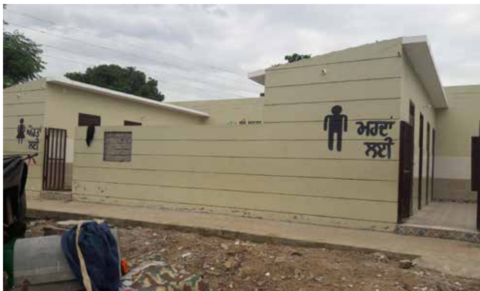
Diese Toilettenanlage hat YFC für Familien von Wanderarbeitern und Wanderarbeiterinnen gebaut.
